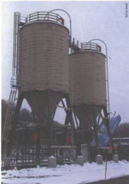
Silo de 250 t et camion de livraison. Le remplissage se fait par le haut. Le sel est pulsé directement depuis le camion Silo of 250 t and delivery lorry. Filling takes place from the top down. Salt loading is controlled directly by the lorry
